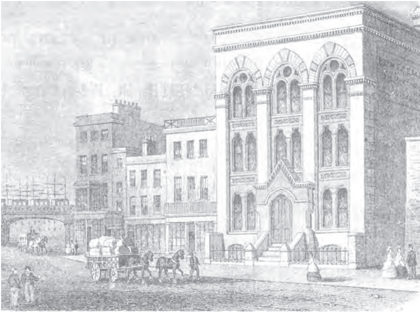
88 West India Dock Road London E14
